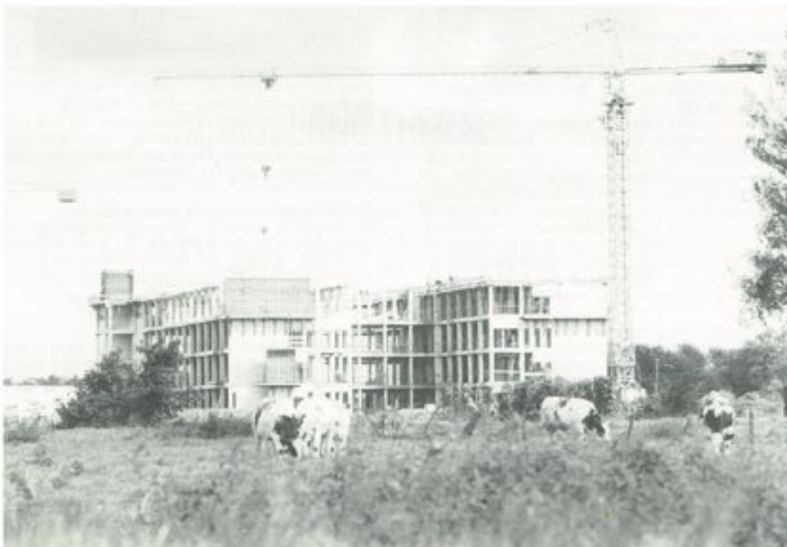
Nieuwbouw in aanbouw.
