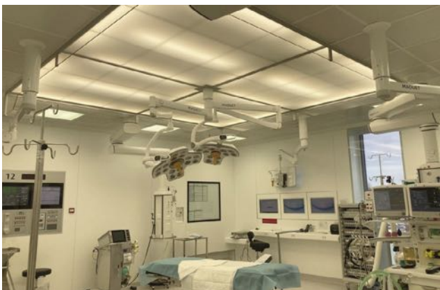
Luchtbehandeling op de OK: het uitgelichte vierkant boven de operatietafel.
